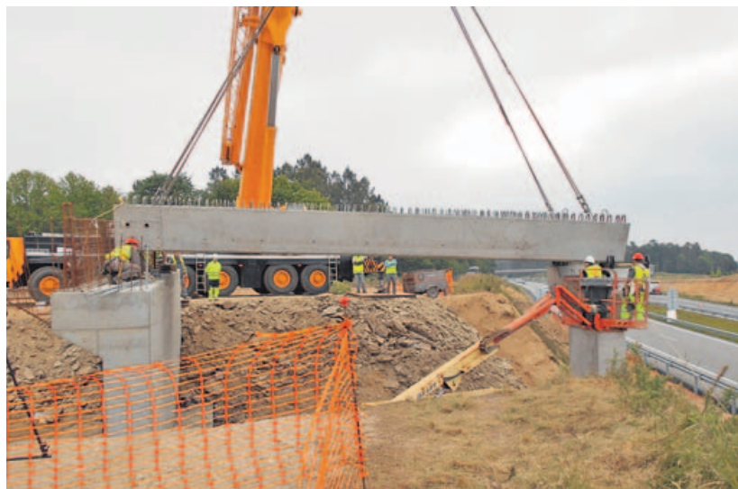
El puente que permitirá el enlace hacia el sur de la AP-9 en Sigüeiro ya está prácticamente ultimado.
